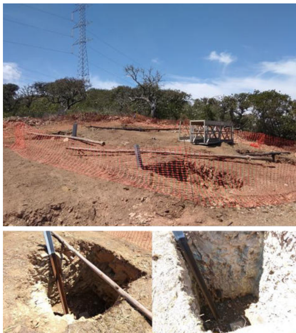
Fundações dos apoios
